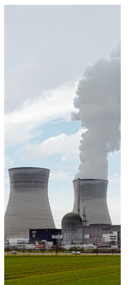
Block B musste vorübergehend abgeschaltet werden. Symbolfoto: Weizenegger
